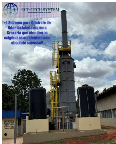
Lavadores de Gases para Controle de Odor
